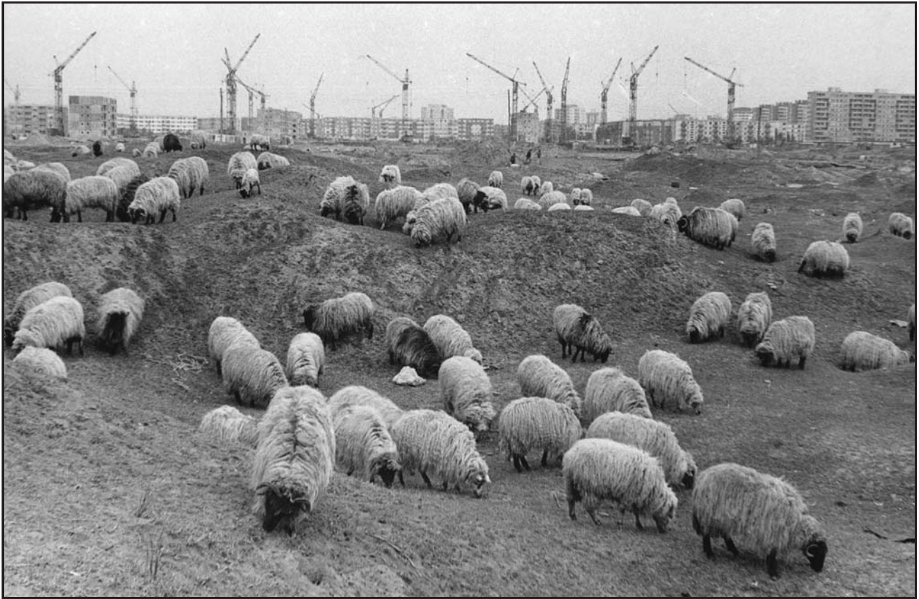
Extindere (cartier Craiovița Nouă - Craiova -1970)
